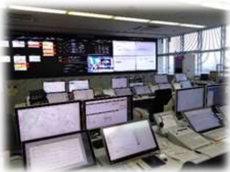
高機能消防指令センター
