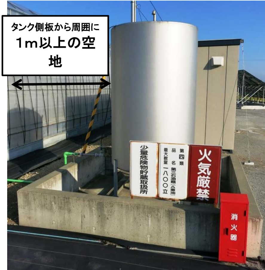
屋外貯蔵タンクの設置例
